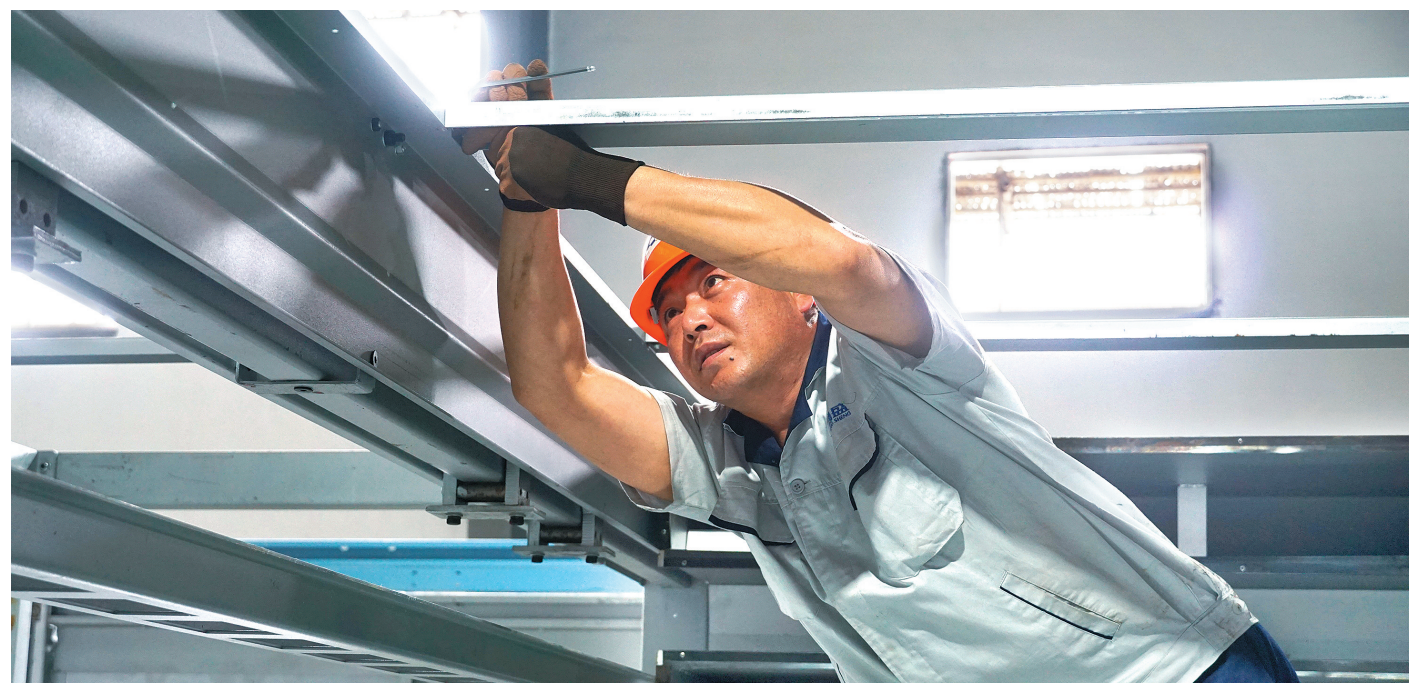
5月14日,浙江鸿盛新材料生产科研基地项目的厂房内正在进行设备安装。“PTFE生产线、热定型生产线以及针刺毡生产线的主体设备已安装完成,下步将进行调试。”浙江鸿盛非织造厂厂长黄尚步说。
